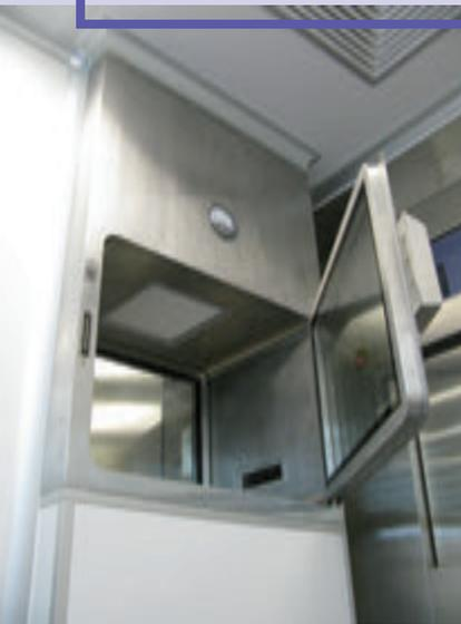
A Reintech destaca algumas novidades, como a supressão dos cantos arredondados em alumínio nas junções verticais dos painéis, utilizando técnicas construtivas que permitam respeitar a limpeza. Os cantos arredondados de interface com o piso, antes confeccionados em alumínio, também têm sido suprimidos, e incorporados ao próprio piso, formando uma superfície lisa e contínua até o painel.
