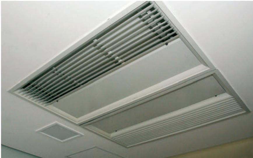
Fancoletes de alto desempenho, desenhados para terem baixa altura foram instalados no forro dos apartamentos. O sistema é dotado de atenuadores de ruído no insuflamento e retorno, garantindo baixo nível de ruído durante o funcionamento
