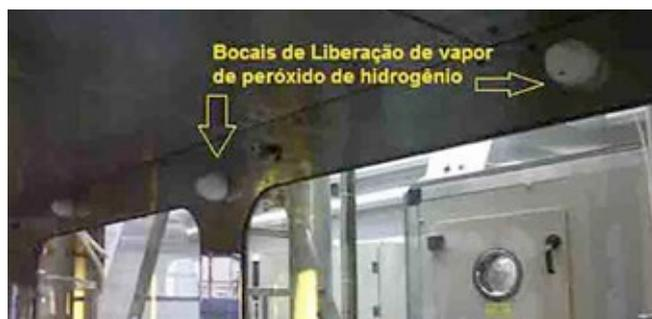
Figura 4: Bocais de liberação de vapor de peróxido de hidrogênio durante o processo de descontaminação
