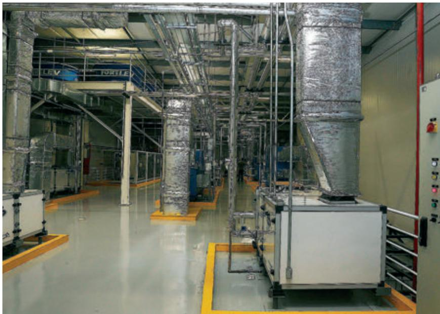
Boa distribuição de equipamentos no piso técnico facilita atividades de manutenção. Espaço abriga os equipamentos de ar-condicionado e utilidades
