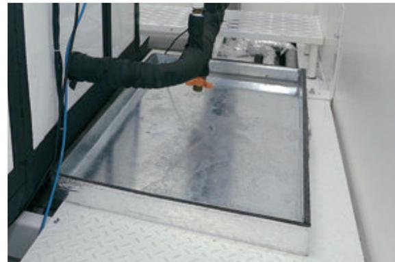
Plataforma metálicas foram criadas para abrigar os fan coils dedicados às áreas de envase e manipulação. Sistema de amortecimento evita que vibrações sejam transferidas ao prédio e bandeja de condensação evita gotejamento
