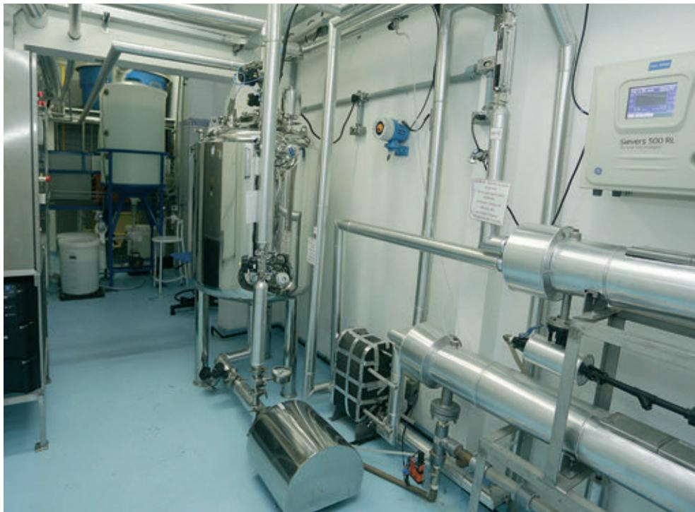
Moderno sistema de água WFI utiliza Termocompressor Stillmas, importado da Itália
