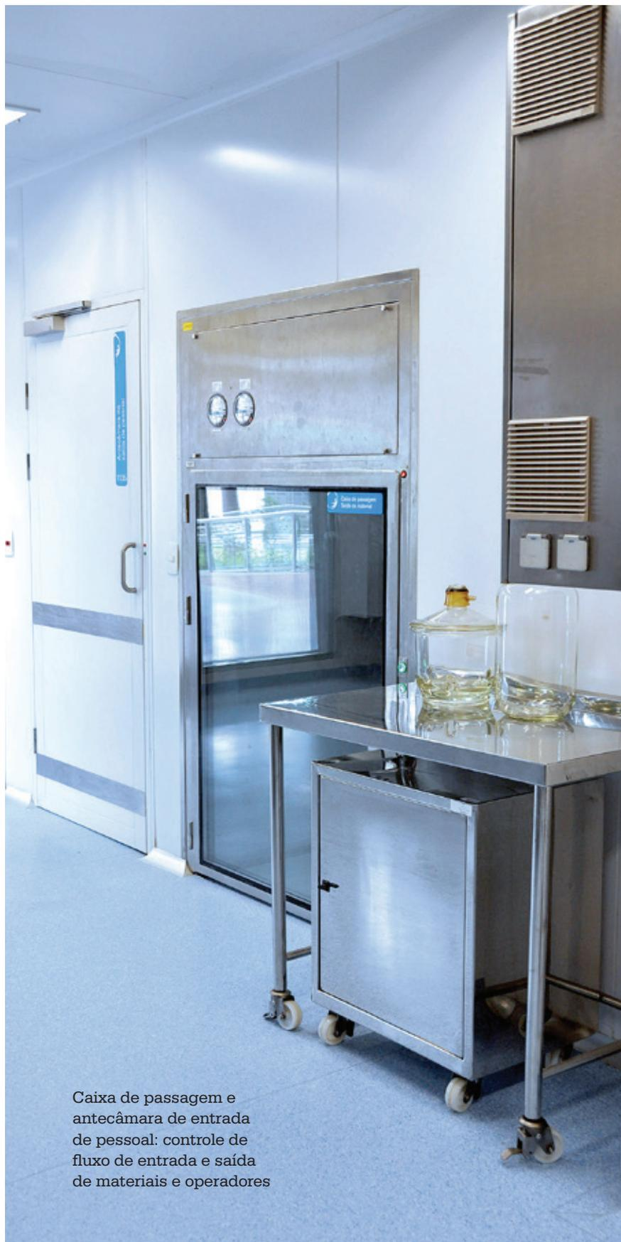
Caixa de passagem e antecâmara de entrada de pessoal: controle de fluxo de entrada e saída de materiais e operadores
